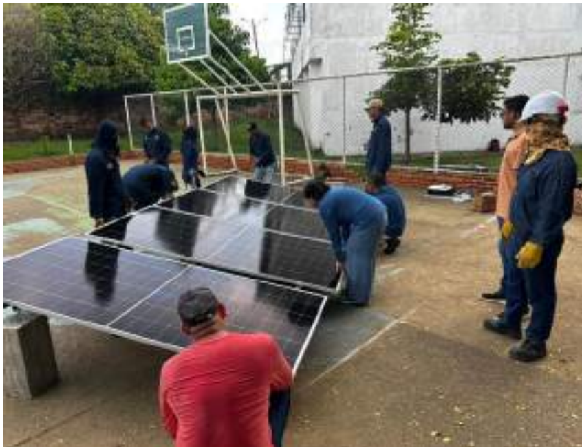
Práctica montaje KIT Paneles Solares
